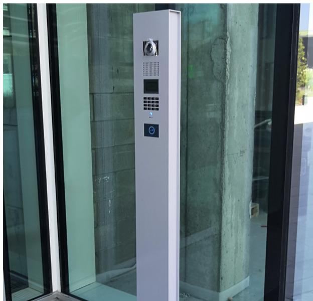
L'ensemble du système d'interphonie a été connecté au système de gestion des bâtiments Siemens Siveillance pour la gestion et le diagnostic.
